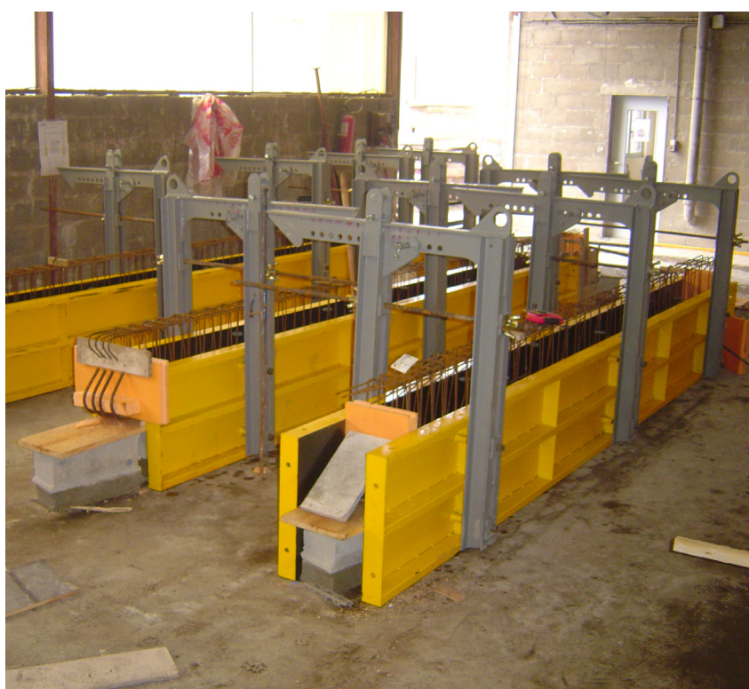
Atelier de préfabrication - Chaptard - Monluçon
