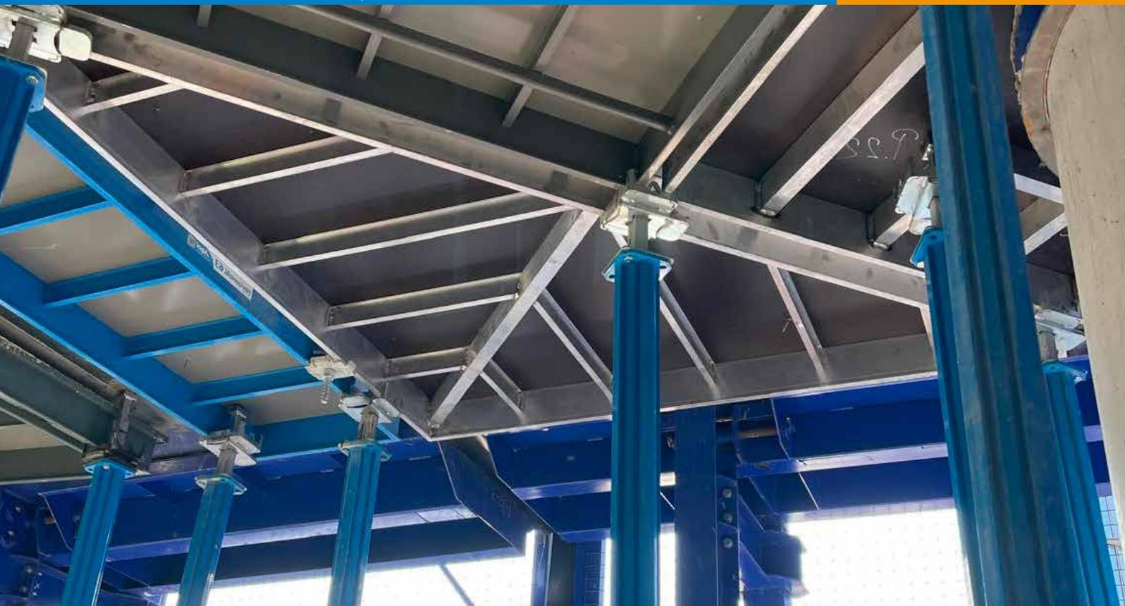
La gamme HorizontAL est un coffrage de type panneau destiné aux grandes cellules, particulièrement adapté à la construction de bâtiments fonctionnels. Une tête d'étais unique, simplifie le montage.
