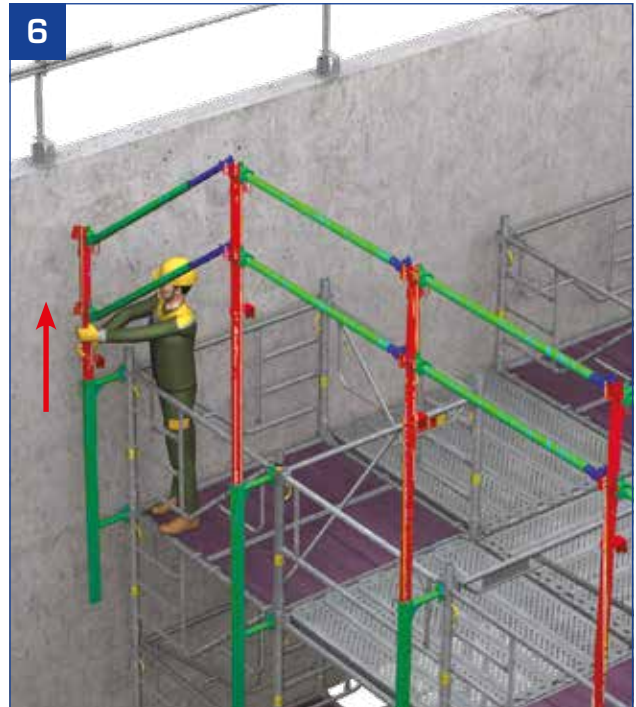
- Die Schritte 4 und 5 Rahmenabstand pro Rahmenabstand wiederholen.
