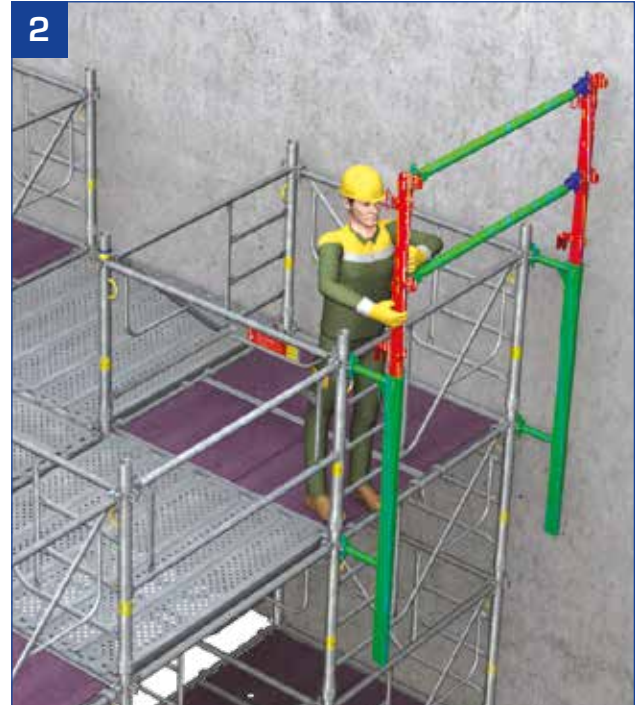
- Anbringen der 2 ausziehbaren Streben des Schalungsgeländers MDS an den Stielen des Schalungsgeländers MDS.
