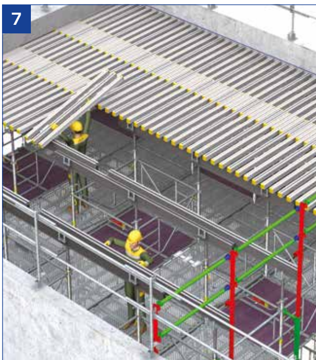
- Montage der Schalungsträger.
