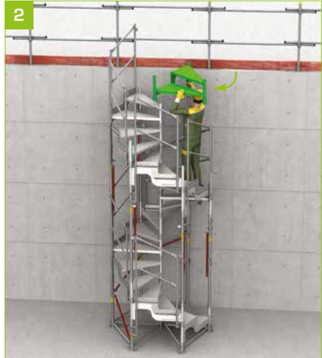
- Pose d'un module 2 marches.
