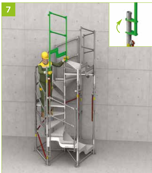
- Pose d'un garde-corps. Les garde-corps se montent depuis le niveau inférieur.
