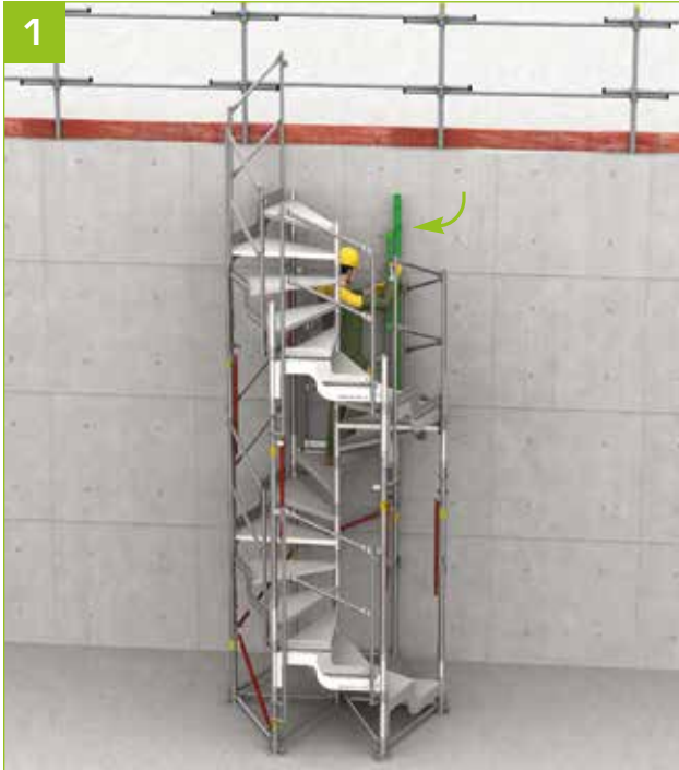
- Pose d'un poteau.
