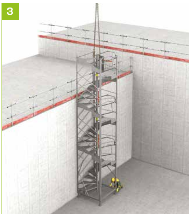
- Pose au sol et mise à niveau de l'Escalib MDS.
