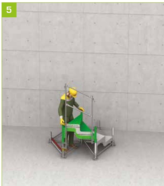
- Pose d'un module 2 marches.
