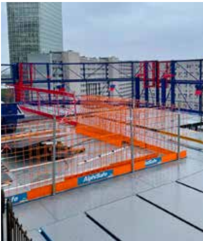
Zwischensicherung, die das weitere Einsetzen der Schalung ermöglicht
