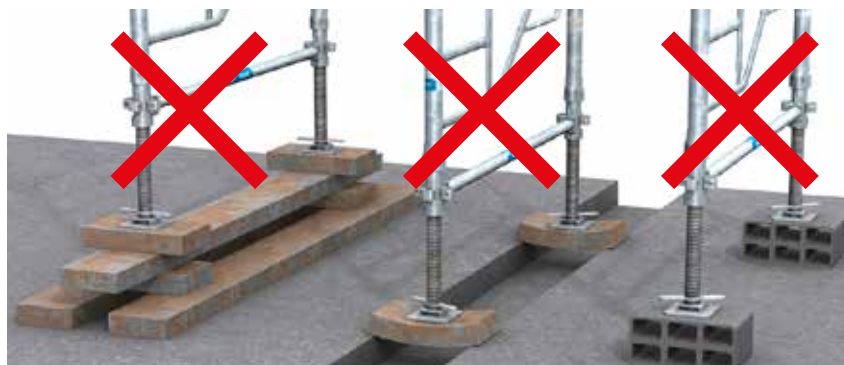
Empilage excessif de cales
