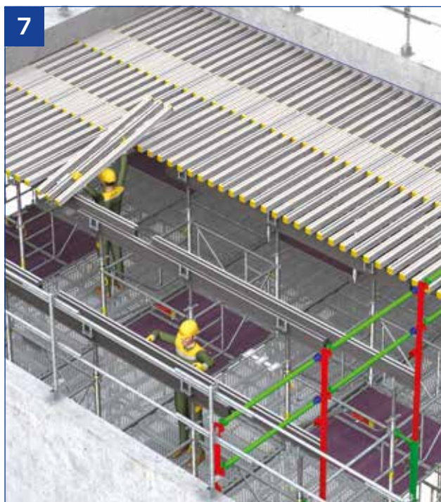
- Pose des poutrelles.
