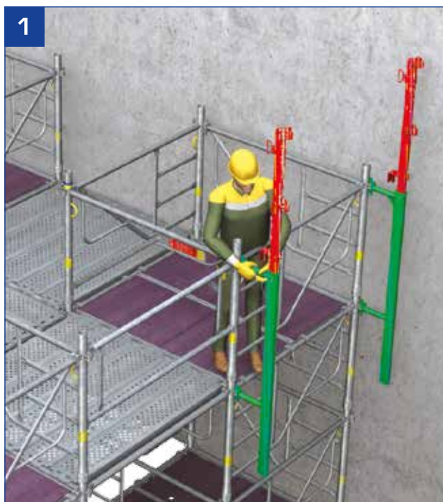
- Pose de 2 montants du garde-corps de coffrage MDS sur la tour d'étalement.
