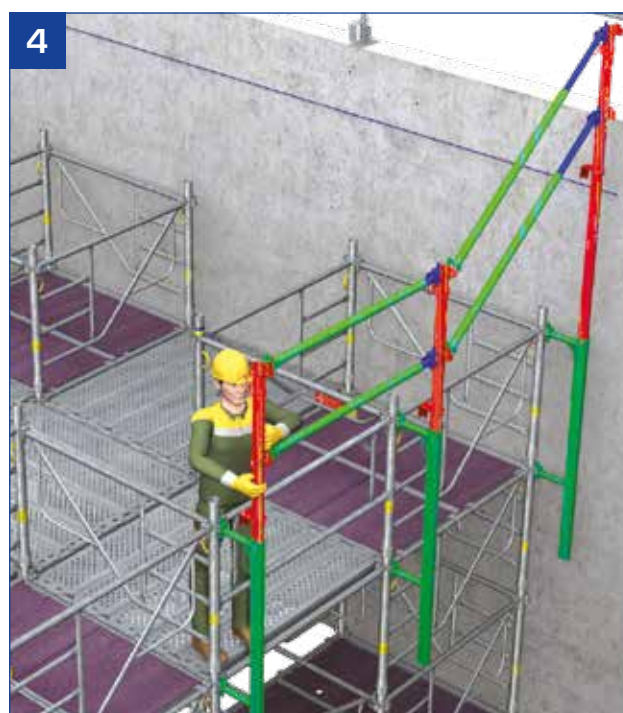
- Poursuivre le montage dans la maille voisine avec la pose d'un montant et de 2 lisses.
