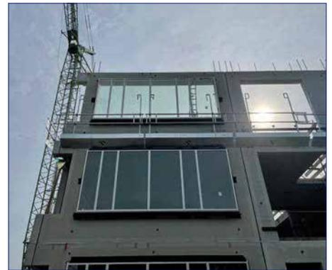
Après la mise en place des murs préfabriqués et le prémontage de la VT Console de façade, les différentes unités de console peuvent être grutées, les consoles de réception étant accrochées aux vis à brides M16x60. Dès que les élingues de grue sont retirées, le système est utilisable.
