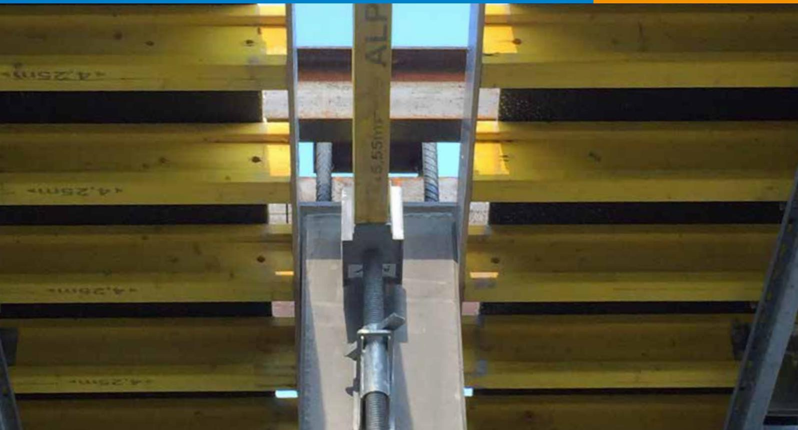
Ce sabot s'utilise avec toutes les poutrelles du marché qui sont compatibles avec la fourche double entrée. Il peut être fixé simplement, sur un voile, un poteau ou une poutre, à l'aide d'une vis à béton.
