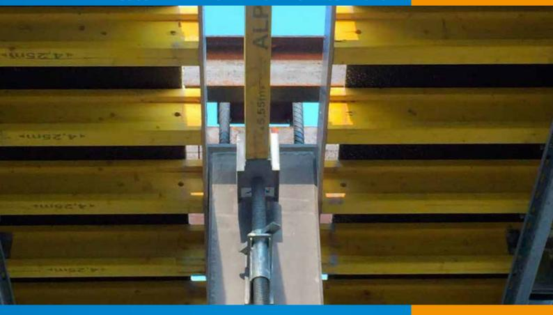
Dieser Stützschuh kann mit allen marktüblichen Schalungsträgern eingesetzt werden, die mit der Trägergabel mit zwei Einlegerichtungen kompatibel sind. Er kann ganz einfach mittels einer Betonschraube an einer Wand, einer Gebäudestütze oder einem Gebäudeträger befestigt werden.
