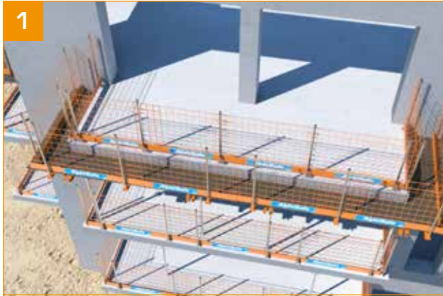
1 - Après bétonnage et mise en sécurité du balcon, procéder au décoffrage.
