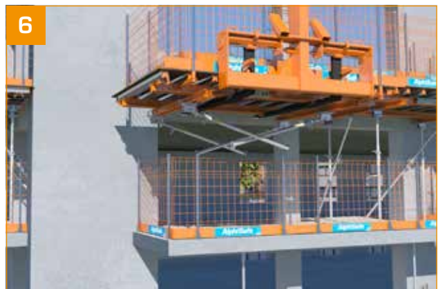
6 - Retirer la TopTable. - Mettre en place les étais de séchage.
