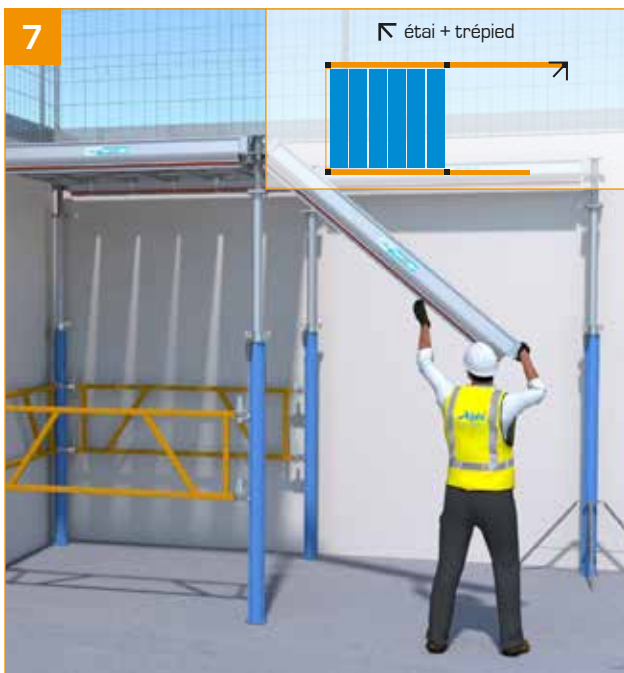
- Mise en place d'une poutrelle primaire sur ST stabilisé.
