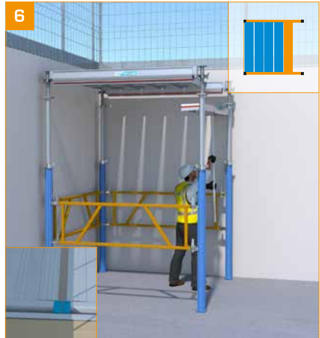
- Mettre en place les panneaux Eco+ de proche en proche à l'aide de la TopPerche. - Accoler les panneaux. - Un vide de 2 cm est conservé.
