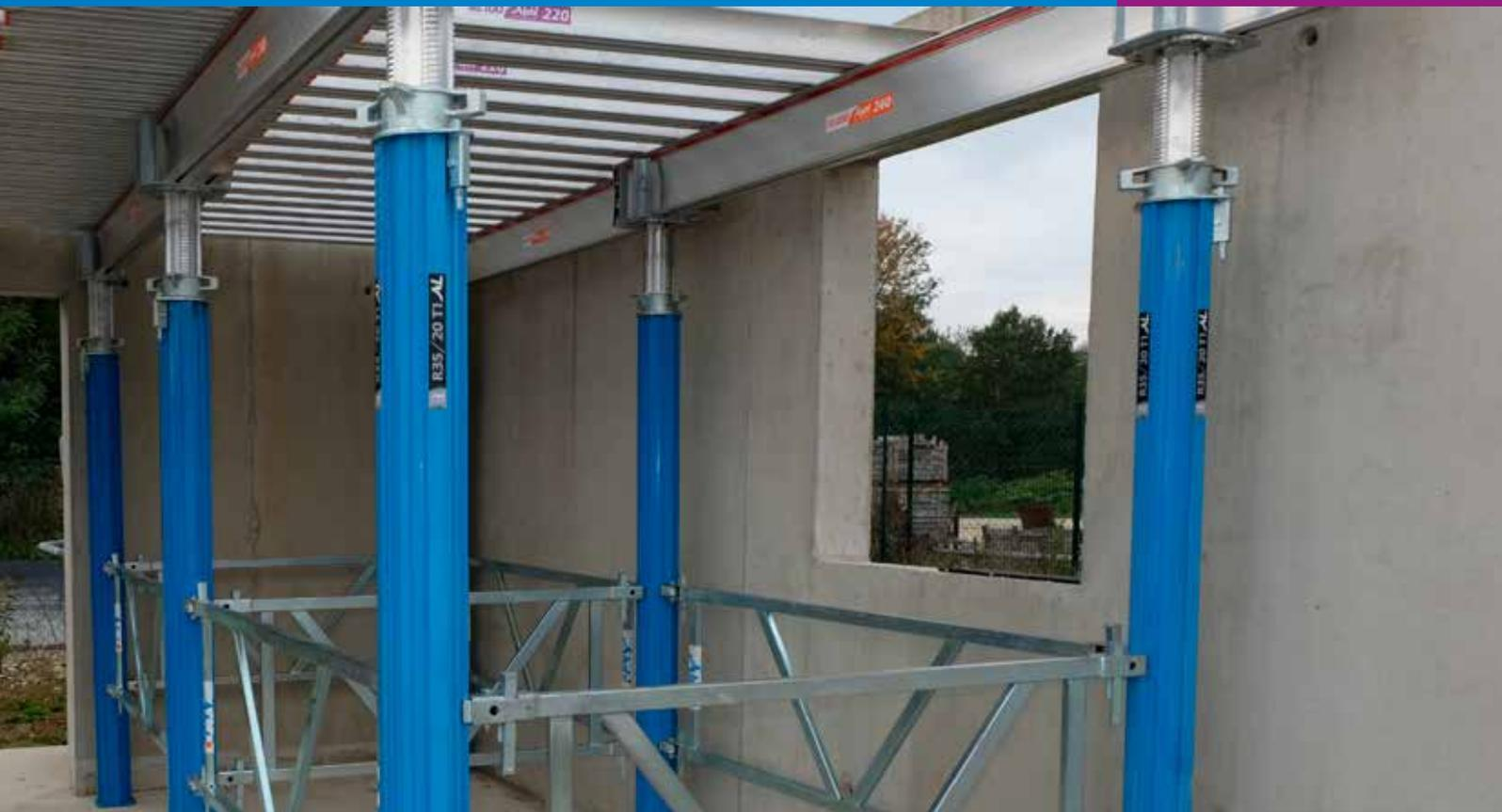
Die Stützen eignen sich für jeden Anwendungsfall bei Schalungsarbeiten und beim Aushärten von Beton.
