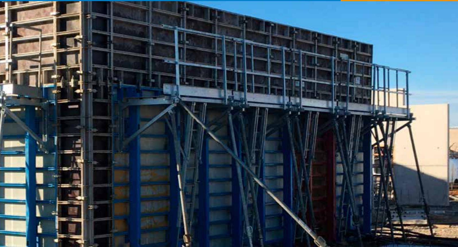
Die modularen und robusten VerticAL-Schalungsplatten aus Aluminium machen sämtliche geometrischen Kombinationen möglich.
