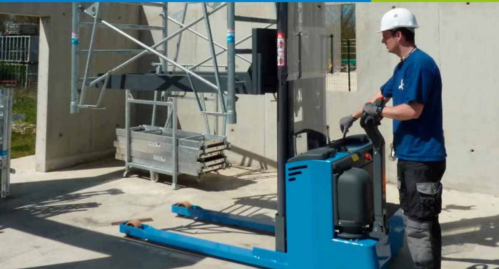
Das Montagegerät für Gerüsttürme ermöglicht eine revolutionär neue Montage von Gerüsttürmen, die im Gegensatz zur herkömmlichen Montage in umgekehrter Richtung vorgeht. Stürze aus großen Höhen und herabfallende Gegenstände werden so vermieden.
