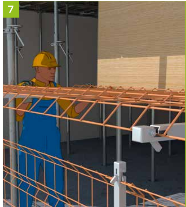
- Sicherstellen, dass das Gitter korrekt in den Befestigungsstellen am oberen und unteren Ende der Pfosten sitzt.
