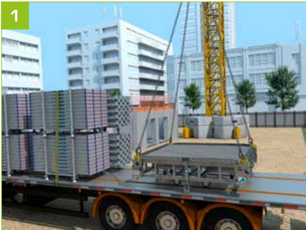
1 - Podium an den 4 versenkbaren Anschlaghaken anschlagen.
