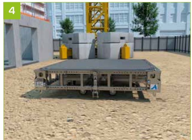
4 - Eine Mutter auf jeder der Seiten von Podium dient zur Abmessungsverstellung von Podium.
