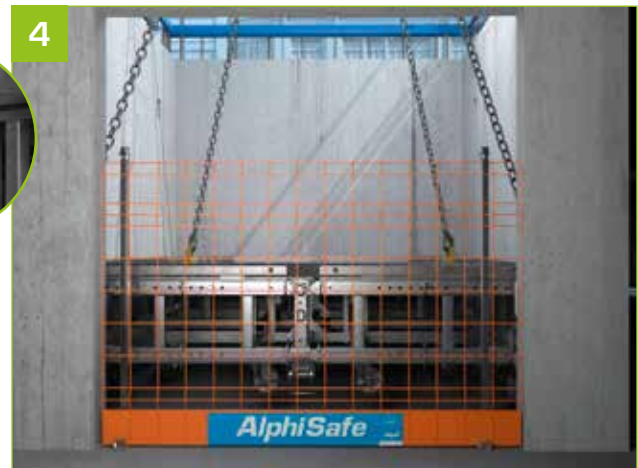
4 - Podium anheben, um die Klemmen in den Wandaussparungen anzubringen.
