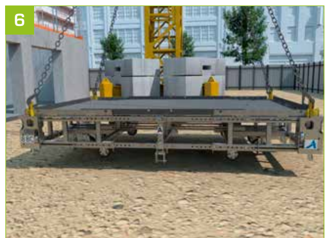
6 - Podium zum Anbringen in der Gebäudeöffnung anschlagen.
