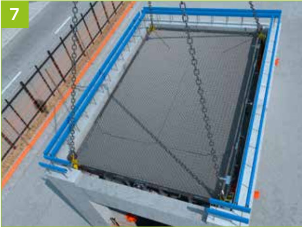
7 - Die Klapp-Klinken werden automatisch ausgeklappt und Podium setzt sich ab.
