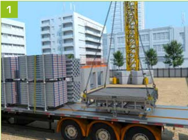
1 - Podium an den 4 versenkbaren Anschlaghaken anschlagen.
