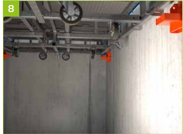
8 - Podium auf seinem unteren Profil absetzen.
