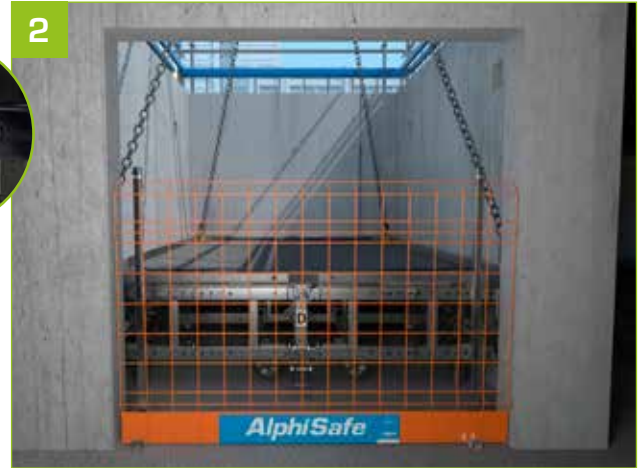
2 - Podium am Boden der zu sichernden Gebäudeöffnung abstellen.
