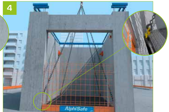
4 - Podium wird mit dem Kran angehoben. - Die Seitenbleche werden automatisch aufgeklappt.
