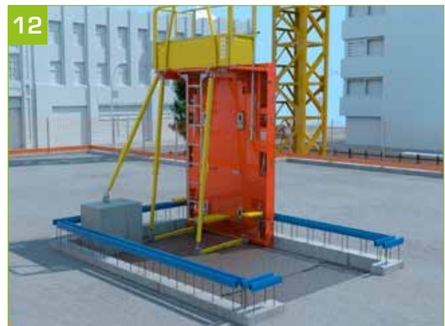
12 - Die Schalwände positionieren.
