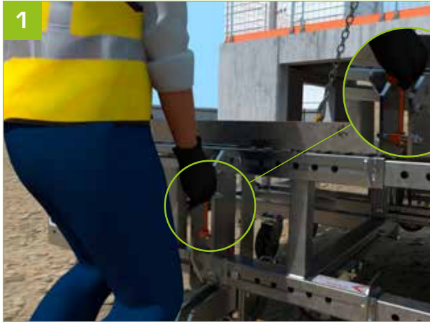
1 - Am Boden die Klemme mit dem Sperrstift in die gesperrte Position bringen.
