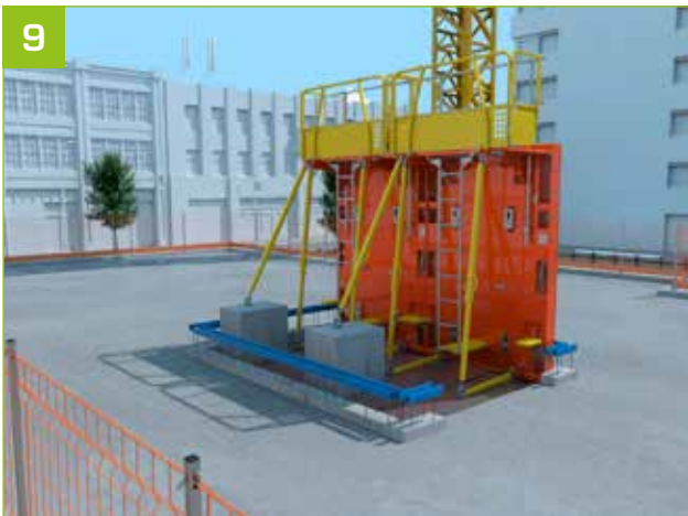
- Die Schalung der Wände vornehmen.
