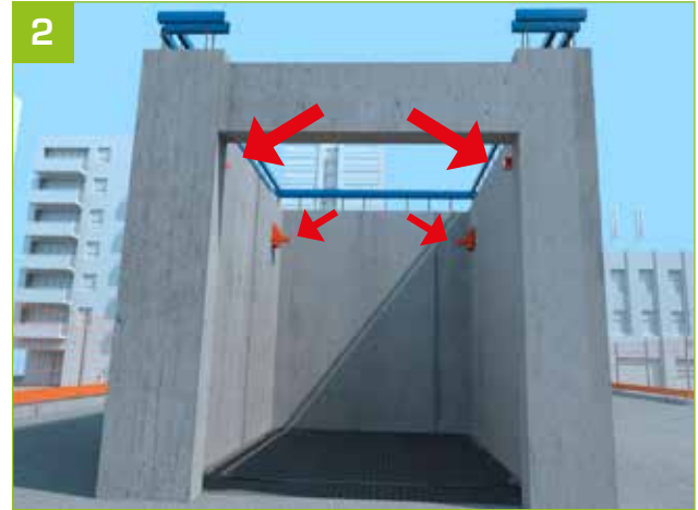
2 - Die Klapp-Klinken werden von innerhalb der Öffnung in die Aussparungen eingebracht.
