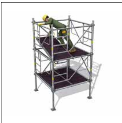
- Aufstieg zur obersten Ebene und Einbau des zweiten Durchstiegs elements.
