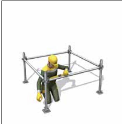
- Aufbau und waagrechte Ausrichtung
