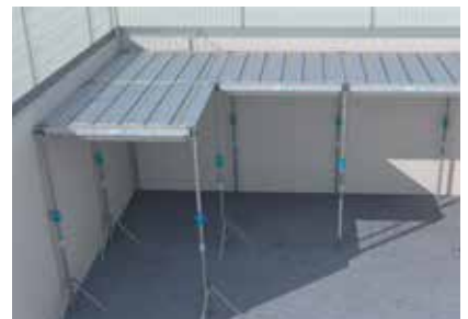
Die ausziehbaren Hauptträger ermöglichen, sich näher an die Wand zu bewegen
