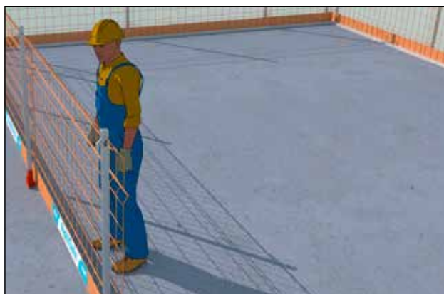
- Die Gitter sind am Kopf durch eine Abhebesicherung verriegelt und am Fuß durch eine Umdrehung blockiert.
