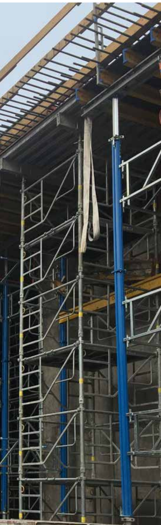
Baustelle in der Schweiz Kunde: Induni Ort: Genf
