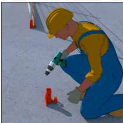
- Befestigen Sie den Adapter auf seiner Oberfläche. Eine Betonschraube mit einem Durchmesser von mindestens 12 mm ist empfohlen.
