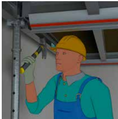
Der in die Stütze integrierte Ausschalen-Fallkopf erlaubt eine schnellere Taktplanung der Alu-Struktur
