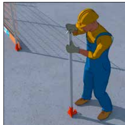
- Clipsen Sie den Adapter in den Pfosten.
