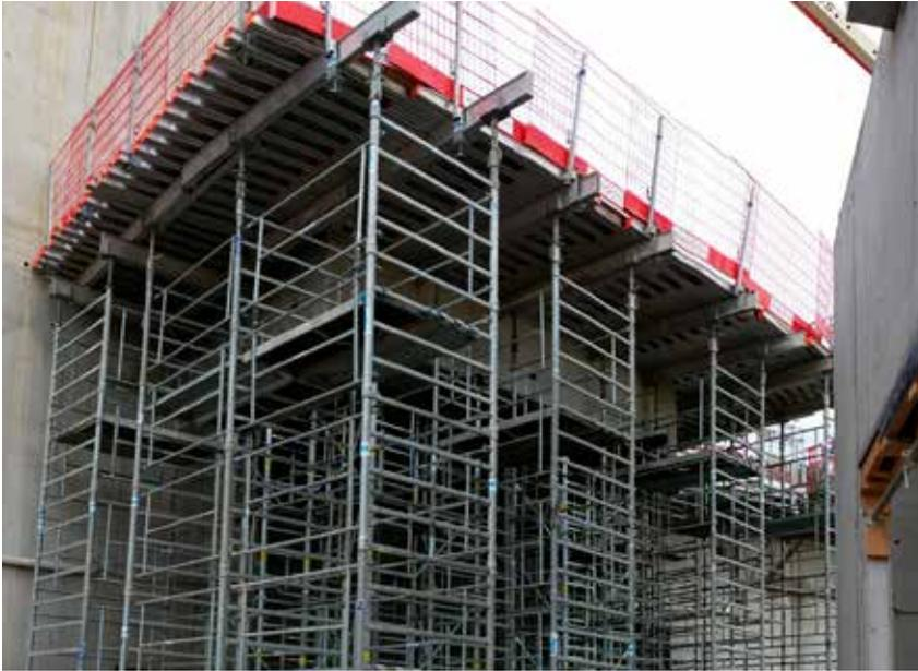
Alphi a su répondre à ces contraintes avec ses tours d'étaieiment : Tour A120 et TourÉchaf, conformes à la recommandation CRAMIF NT24. Elles se caractérisent par un montage et un démontage effectués en toute sécurité, limitant ainsi les risques de chutes de hauteur pour l'équipe de 30 monteurs mobilisée au plus fort du chantier.
