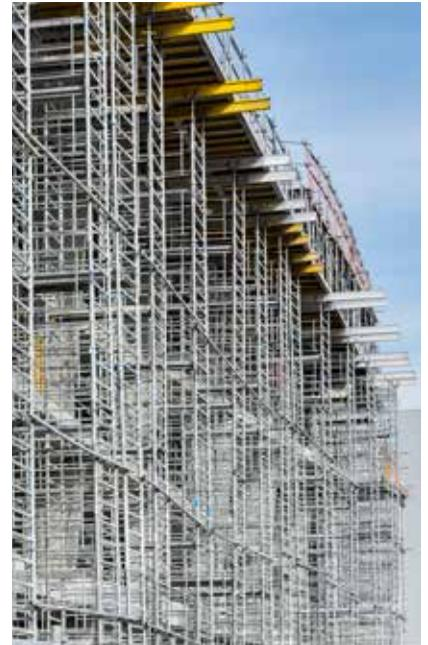
Les systèmes de coffrage Alphi, TopDalle et MaxiDalle, ont répondu aux attentes de l'architecte du projet qui souhaitait des rendus de surfaces différents à l'intérieur du bâtiment et en périphérie, plus lisses et plus esthétiques à cet endroit.
