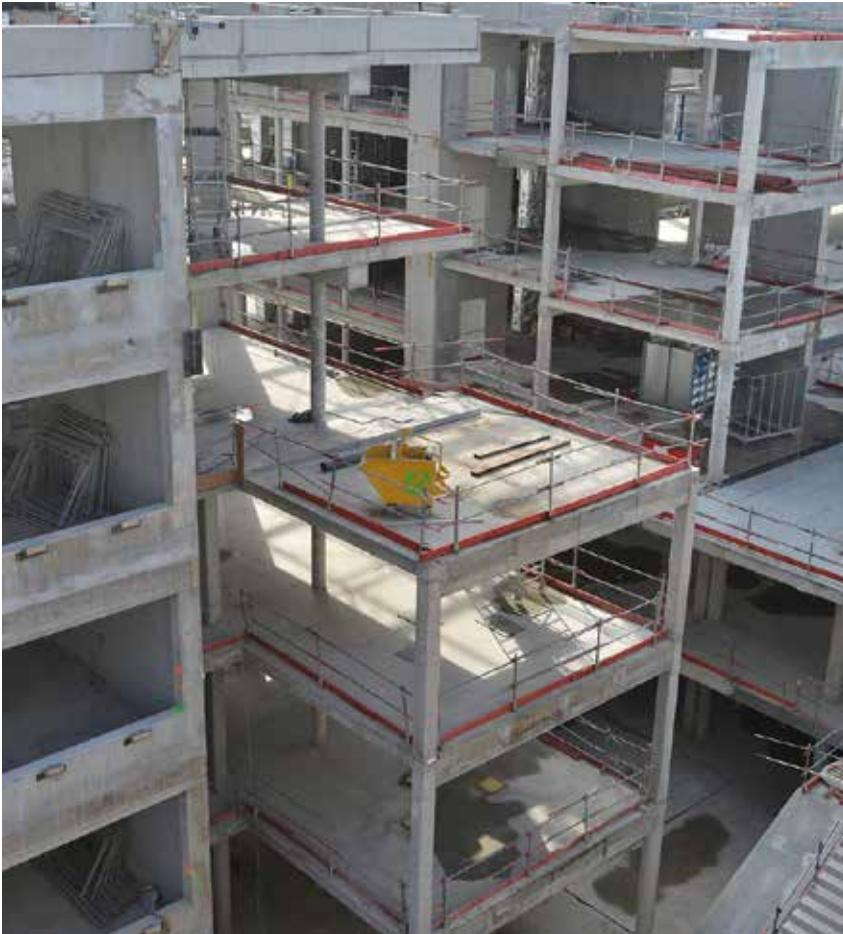
Plusieurs méthodes constructives ont été retenues sur ce chantier d'une envergure exceptionnelle : des planchers coulés en place, des dalles alvéolaires et des prédalles.
