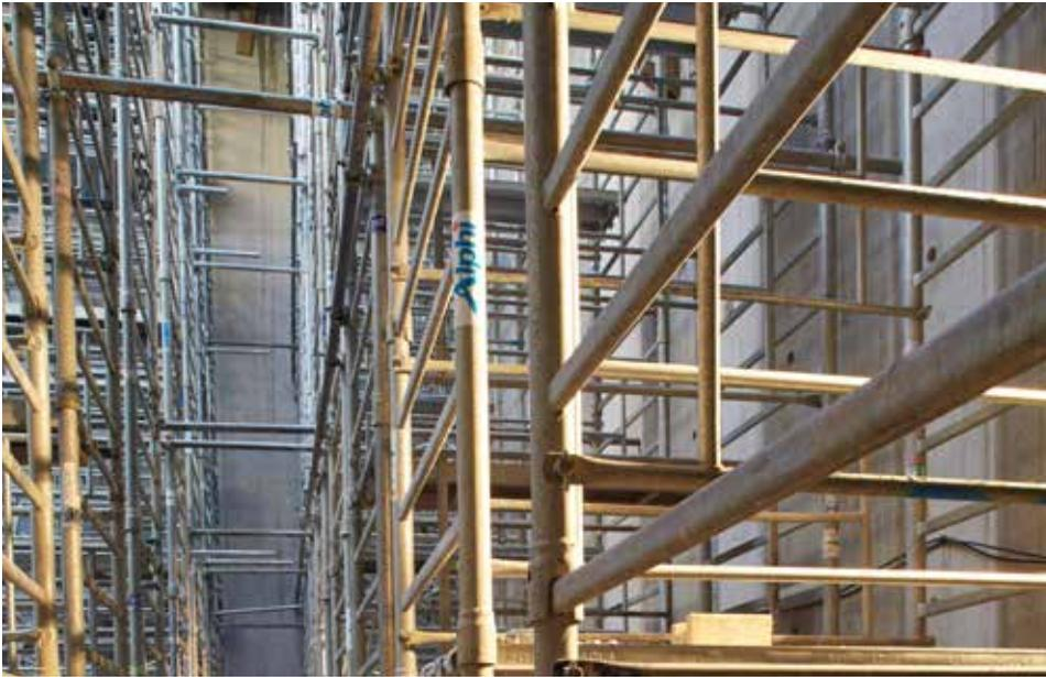
La solution complète proposée par Alphi a consisté en la mise en place de 1 100 tonnes d'étaieement composé de Tours A120 et de TourÉchaf sur 6 niveaux, pour une hauteur allant jusqu'à 49 m.
