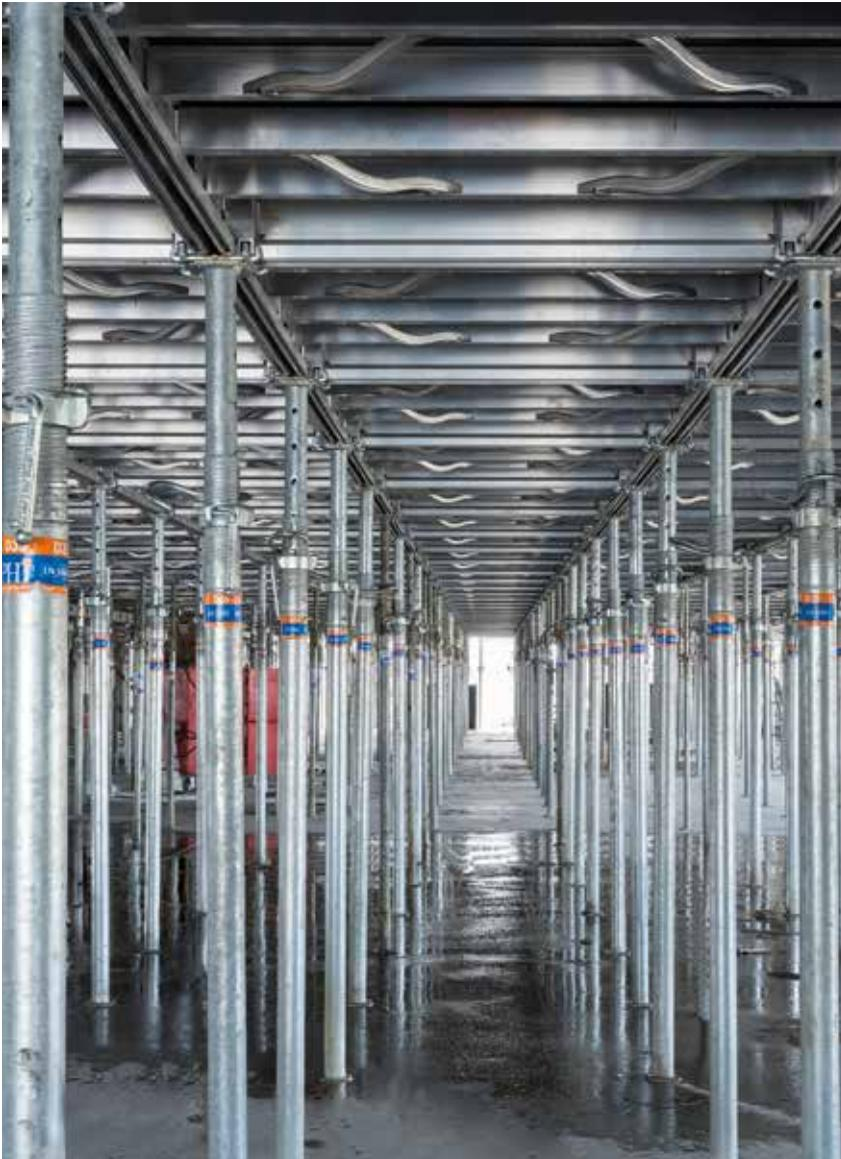
*Le coffrage MaxiDalle est particulièrement adapté aux ouvrages fonctionnels*
