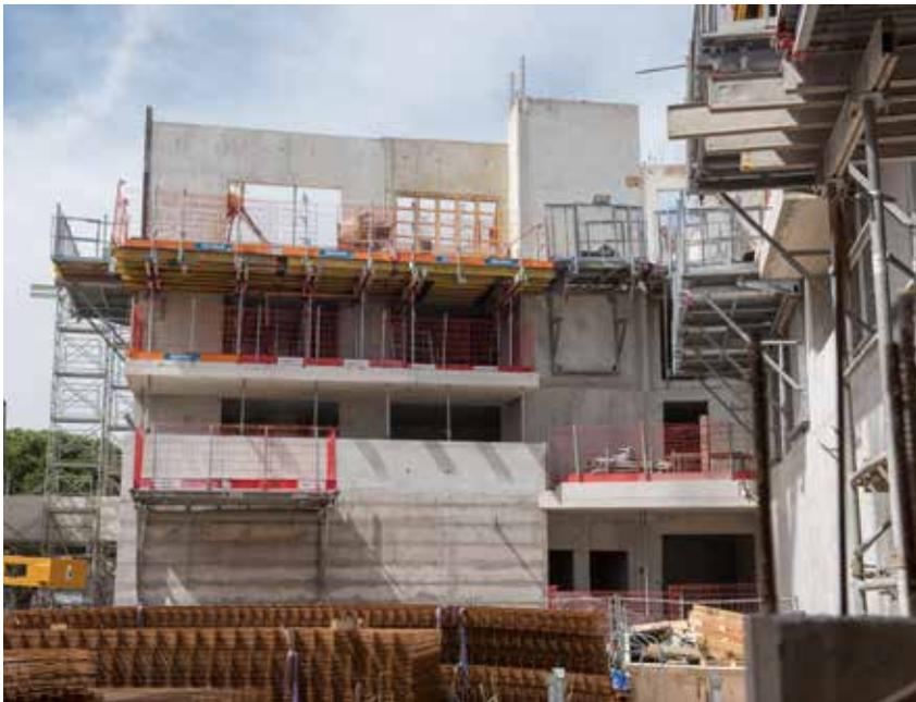
Alphi a su apporter une réponse globale à ces problématiques, chacun des systèmes proposés - coffrage TopDalle Éco particulièrement adapté au logement et tables de coffrage - a satisfait les attentes client. Le système de sécurité collective AlphiSafe nouvellement développé par Alphi a en outre permis une mise en place en toute sécurité.
