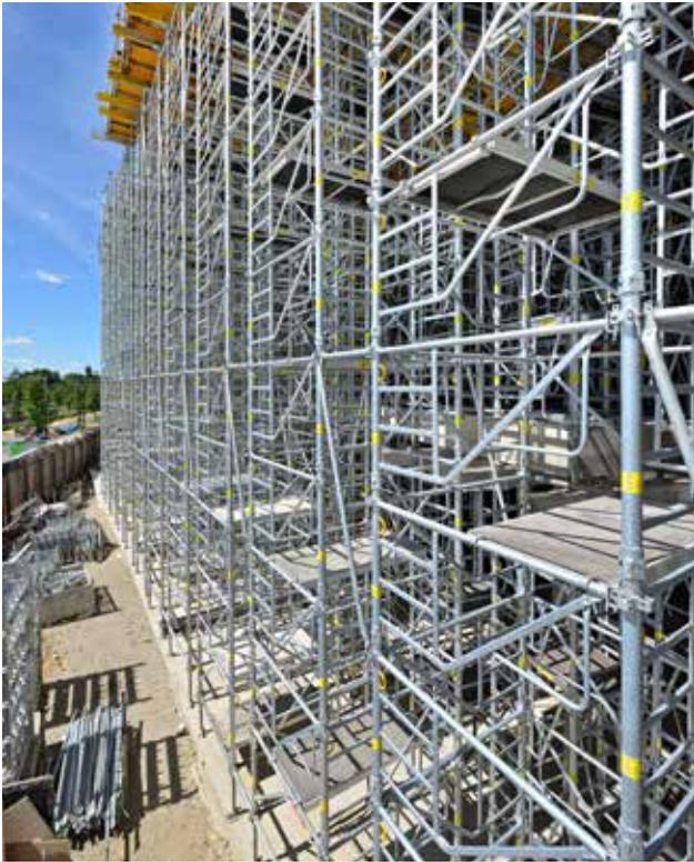
Ce projet revêt deux spécificités : une réalisation en béton architectonique d'une part, une façade avant du bâtiment inclinée d'autre part, ce qui implique de soutenir le poids de la construction pendant toute la durée du chantier, jusqu'à la réalisation du toit.
