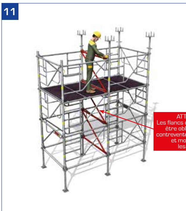
- Mise en place et réglage des vérins de tête. Contreventement impératif avec une moise et une diagonale.
