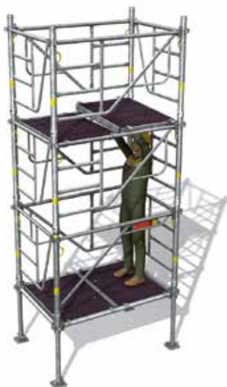
- Déplacement du 2 e plancher à trappe depuis le niveau inférieur.
