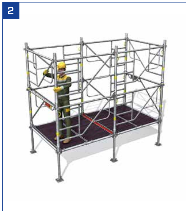
- Montage du 2 e niveau.
