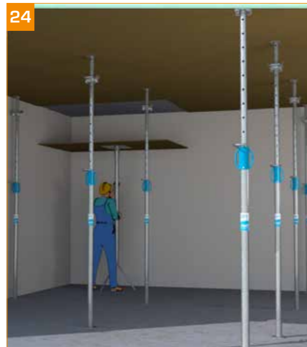
24 - Utiliser un lève-plaque pour retirer le CP.
