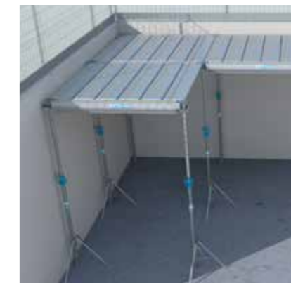
Les poutrelles extensibles permettent de se rapprocher des bords de la cellule
