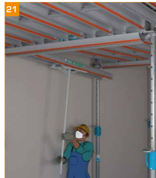
- Décoffrage de la dalle : enlever à l'avancement les cadres C2+ et en dernier les primaires à l'aide de la TopPerche. - Les ranger dans les paniers à roulettes.
