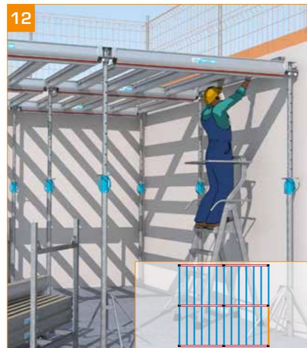
- Terminer la mise en place des poutrelles secondaires.
