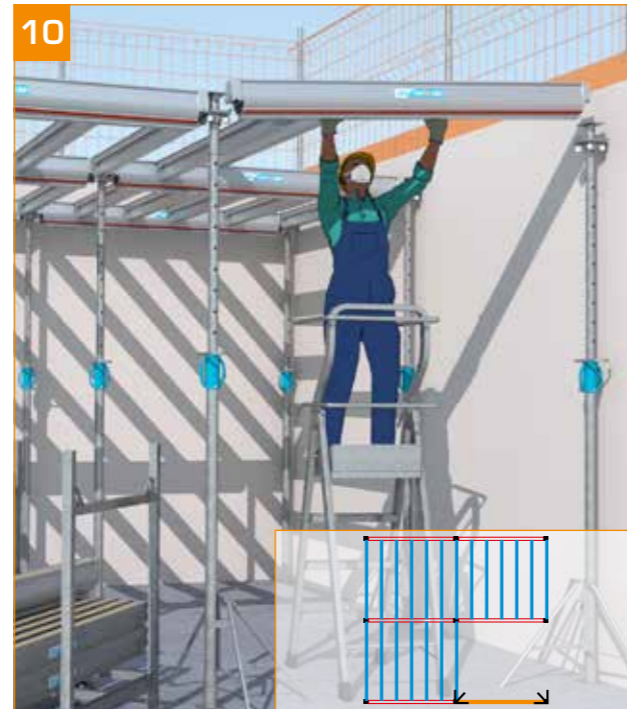
- Mise en place d'une nouvelle poutrelle primaire sur ST.
