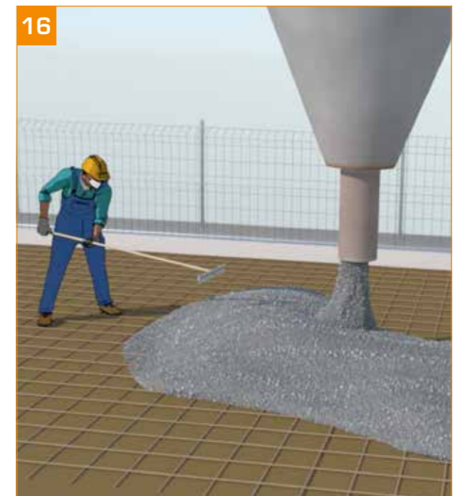
- Réalisation de la dalle béton. → Répartition du béton sur le coffrage sans surcharge des poutrelles et ST.
